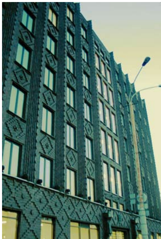
Муниципалитет в Таллине. Эстония
