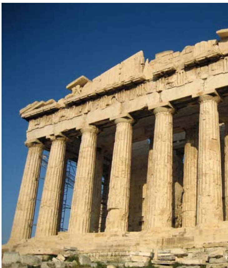
Парфенон. Вид с запада. Колонны дорического ордера
